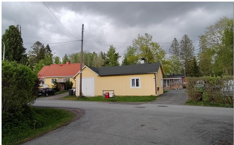
Kuva 2. Valokuva Kytkindadun suunnasta Kiskokadulle. Kuvan keskellä näkyy tontilta purettavaksi aiottu talousrakennus ja sen takaoikealta pilkistää vanhan asuinrakennuksen uudehko lisäsiipi. © Tampereen kaupunki 2022.
